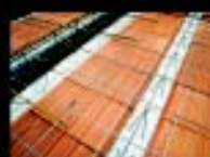
Lajes e Calhas
