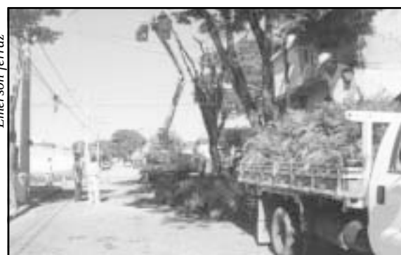
Na quinta-feira (9) o serviço era executado no Central Parque
