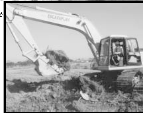
Antes das 9 horas da manhã, as máquinas já começavam a escavar o terreno para construir o “piscinão”
